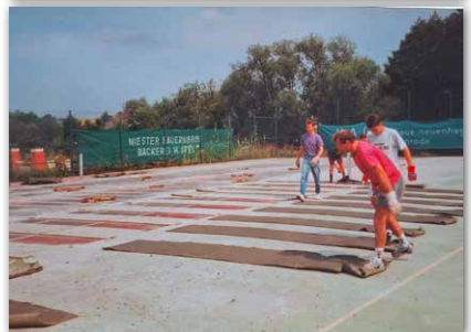
Abbau des ersten Kunstrasenbelages: Knochenarbeit, da der Quarzsand mit dem Teppich Tonnen auf die Wage bringt
